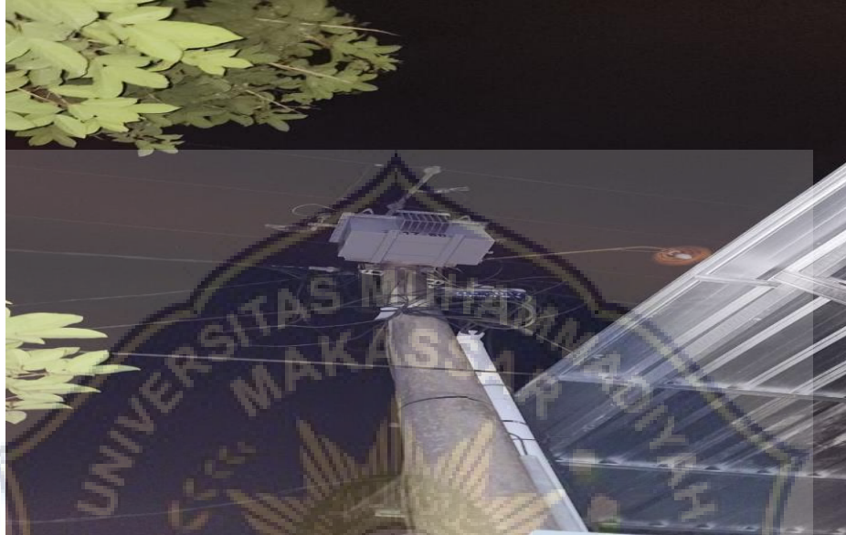
GAMBAR 4. 5 trafo Sisipan Distribusi BMOZ BT50-106 (ulp tanete up3 bulukumba)
