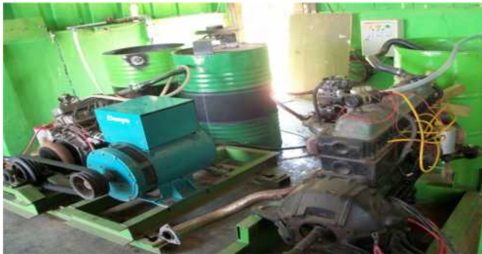
Mesin Pembangkit Listrik Gas Metan
