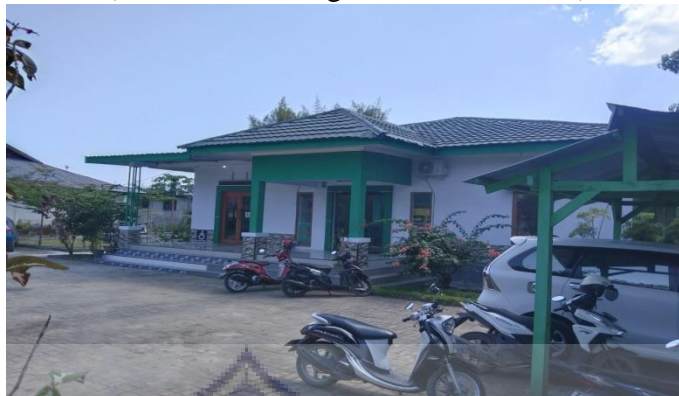
(Gambar 4.1 Bangunan Kantor KUA)
