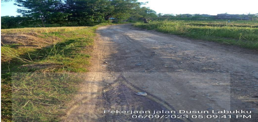
Dokumentasi Perbaikan Jalan
