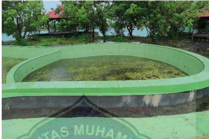
Gambar 32. Kondisis Eksisting Kolam Sumber : Hasil Observasi, 2023
