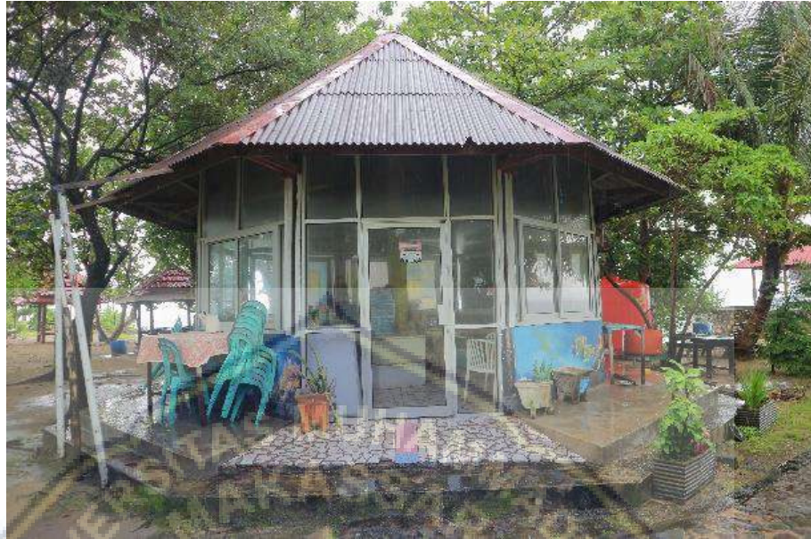
Gambar 31. Kondisi Eksisting Kantor Pengelola Sumber : Hasil Observasi, 2023
