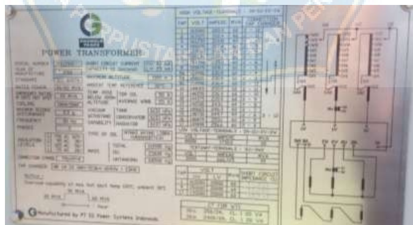
Gambar 4.1. spesifikasi trafo ULTG Panakkukang (Sumber Ultg Pnakkukang)
