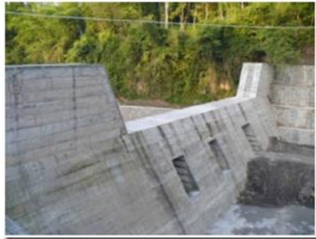
Gambar .2 Bangunan Sabo dam
