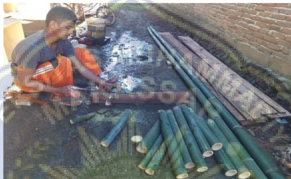
Gambar 4.9 Pengambilan dan Pemetongan Bambu
