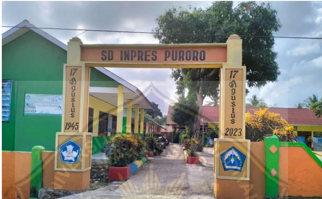
Gambar 1 : Bangunan Sekolah Dokumentasi: Aqilah Salsabila, 18 November 2023
