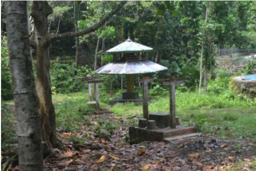
Gambar 7. Gasebo yang Mau di Perbaiki
