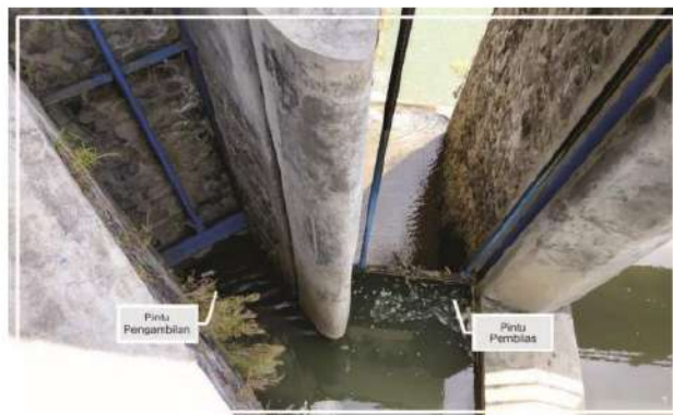
Gambar 9. Pintu pengambilan (Admindpu Kulon, 2020)
