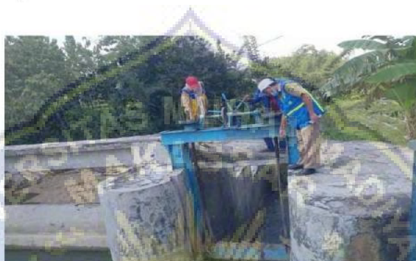
Gambar 8. Pintu air bendung (Dinkominfo Blora, 2022)
