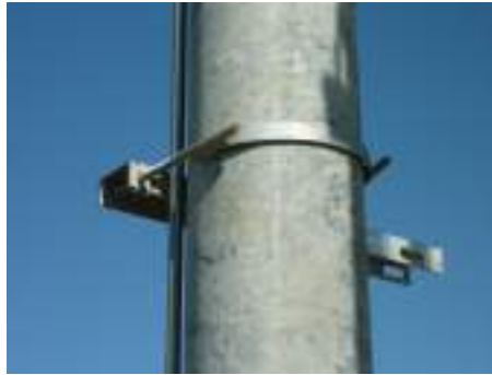
Gambar 2.7 Tiang beton Sumber : Dokumen Pribadi
