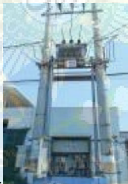
Gambar 2.16 Gardu portal Sumber : Dokumen Pribadi
