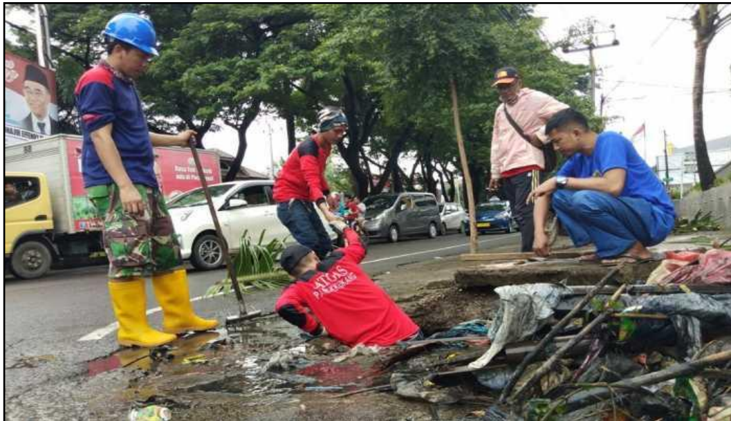
Gambar L. 2 Satgas Drainase Kecamatan Panakukang mengangkat sampah dan juga sedimen di got Jalan Hertasing. (Sulselsatu.com/Hermawan Mappiwali)
