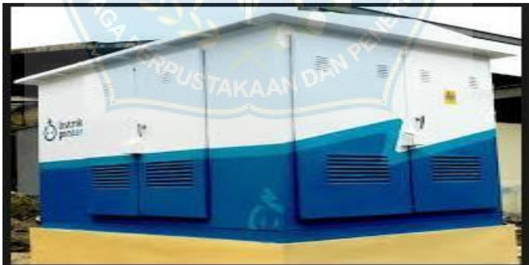
Gambar 2.4 : Konstruksi Gardu Kios
