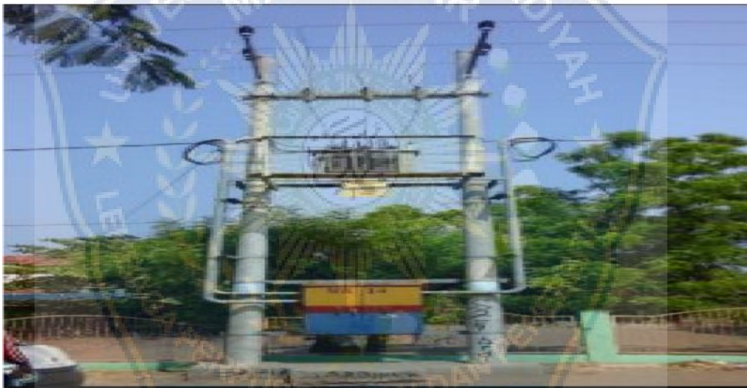
Gambar 2.4.3 : Konstruksi Gardu Portal
