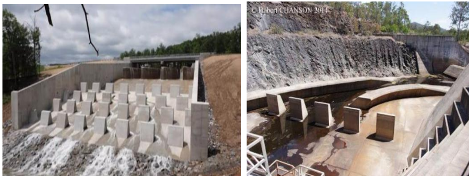
Gambar 8 . Pemasangan Baffle Blocks (Hubert Chanson 2014)
