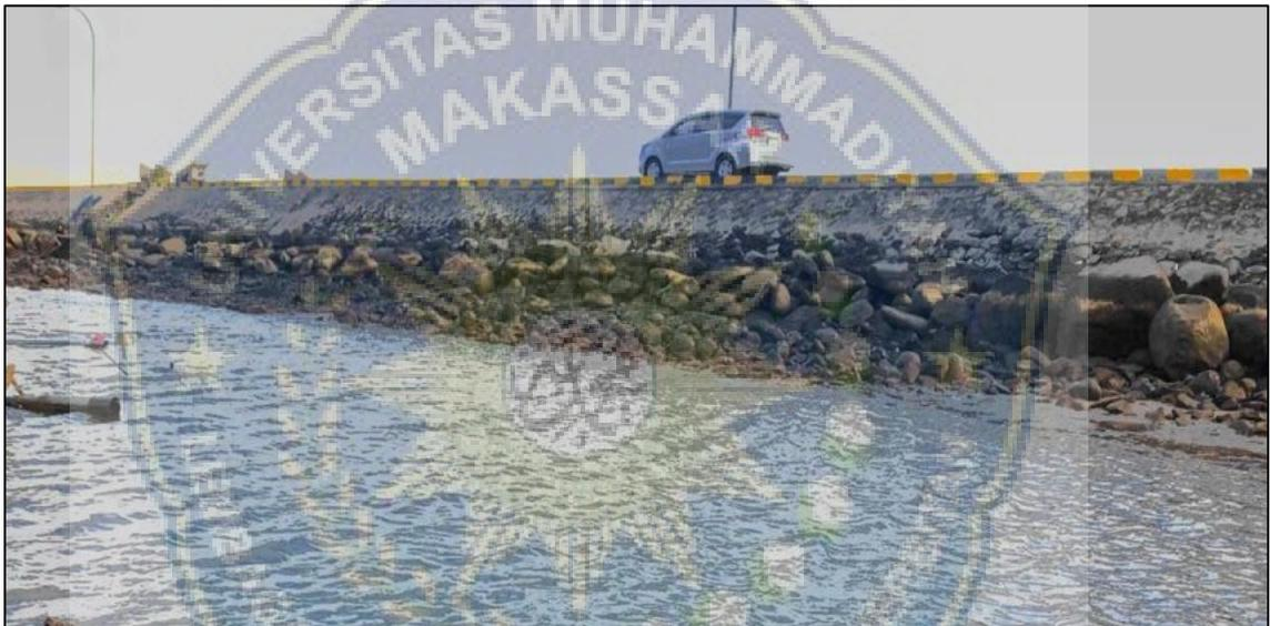
**Gambar 1.1** Kondisi bangunan break water yang mengalami kerusakan
