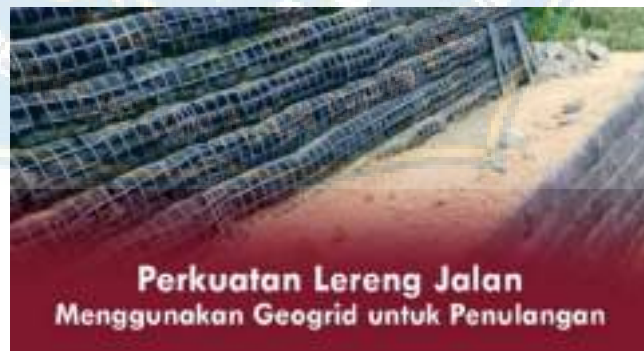
Gambar 2.12 Penggunaan Geogrid Untuk Penulangan
