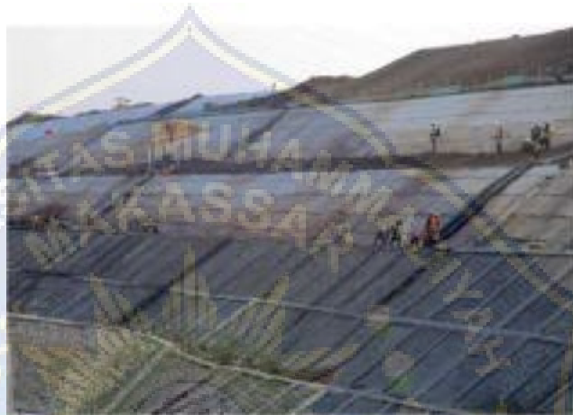
Gambar 2.15 Geotextile Untuk Penahan Tanah
