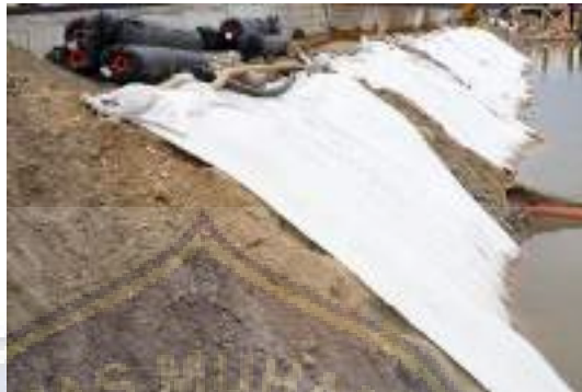
Gambar 2.4 Penggunaan Geotextile Sebagai Dinding Penahan Di Sungai
