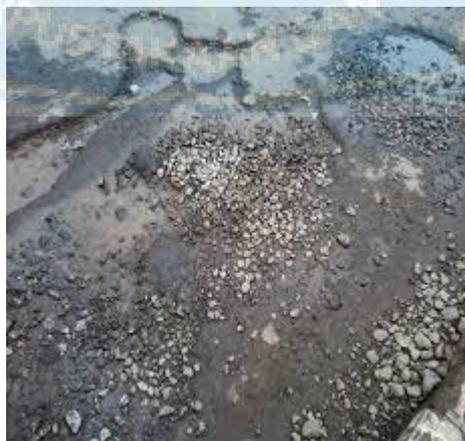
Gambar 12. *Weathring/Raveling* (pelepasan pada butir)
