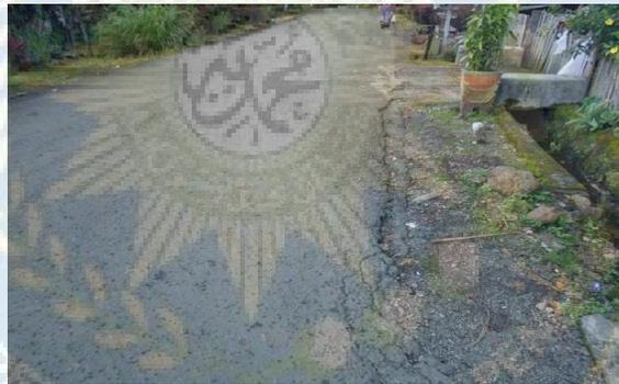
Gambar 4. Cacat Tepi Perkerasan (*Edge Cracking*)
