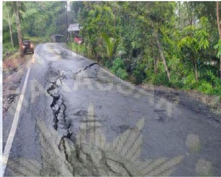
Gambar 7. Retak memanjang dan melintang (*longitudinal & transfer Cracks*)
