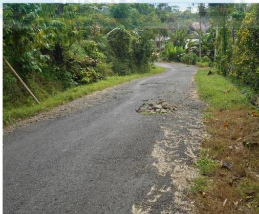
Gambar 9. Lubang (*Potholes*)
