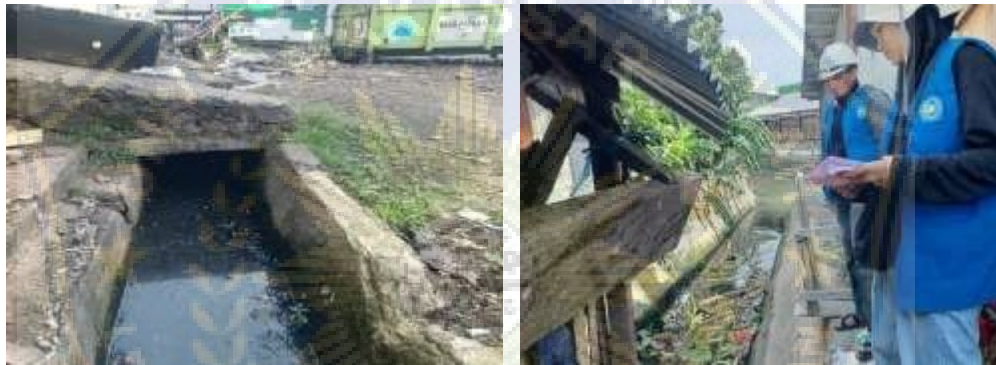
Gambar 42 Saluran Drainase Jalan Terminal Pasar Baru Bantaeng
