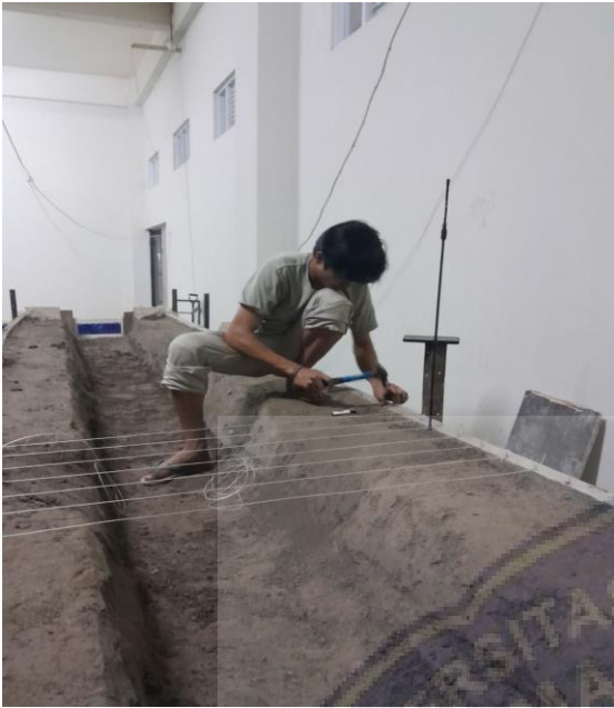
Pemasangan titik pias pada saluran
