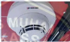
Gambar 3.19 Alarm kebakaran ( Sumber: Google.com)
