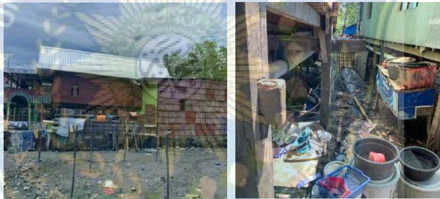
Gambar 4. 6a dan gambar 4.6b Kondisi Bangunan Lokasi Penelitian
