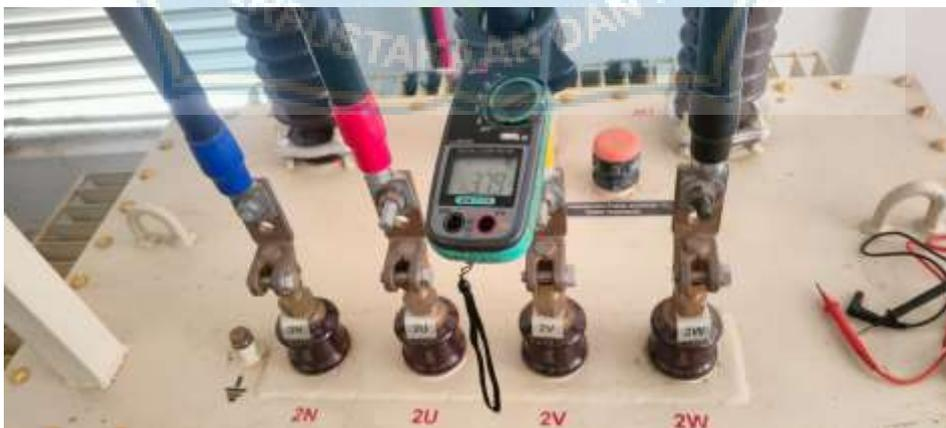
Gambar L. Pengukuran pada arus fasa S
