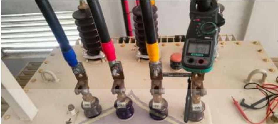
Gambar L. Pengukuran pada arus fasa T
