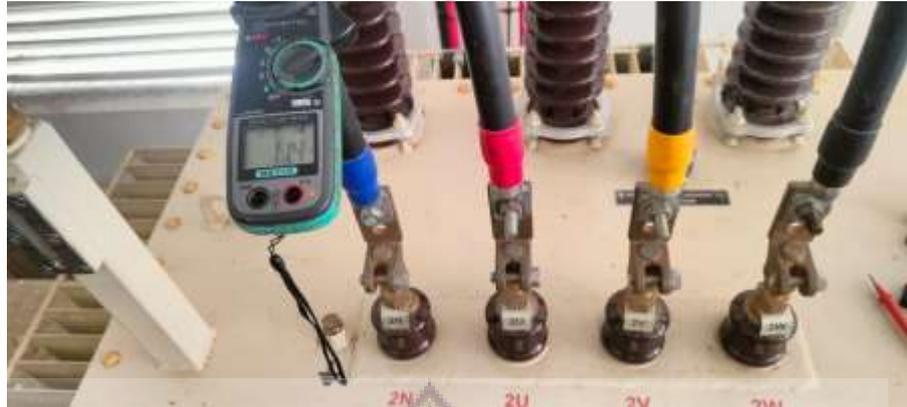
Gambar L. Pengukuran pada arus fasa N
