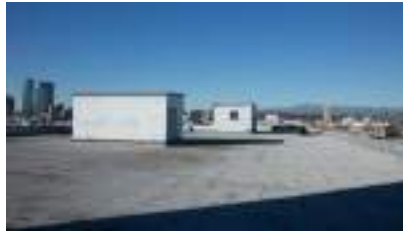
Gambar 3.19. Atap dak beton (sumber : Google.com, 2024)
