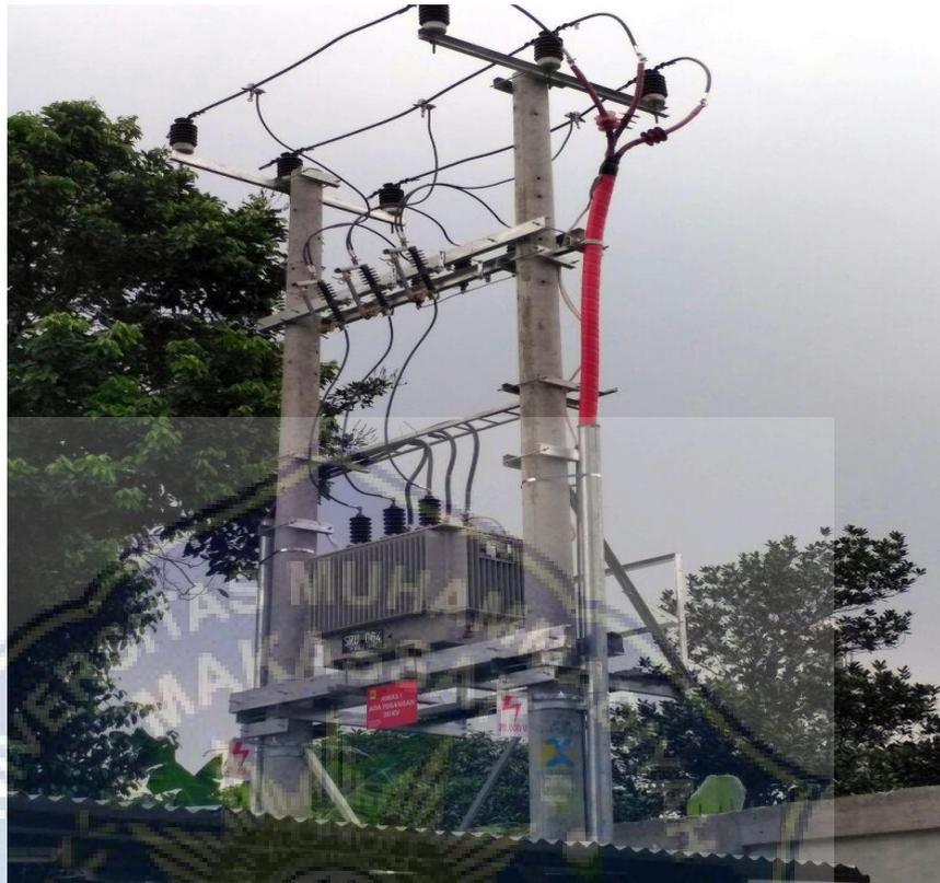
Gambar 2.7 Saluran Udara Tegangan Menengah (SUTM) (PT. PLN (Persero) Buku 5, 2010)
