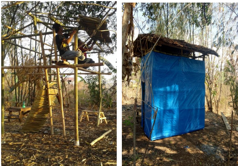
Gambar 8. Proses pembuatan kumbung tempat perawatan baglog dan tumbuh jamur
