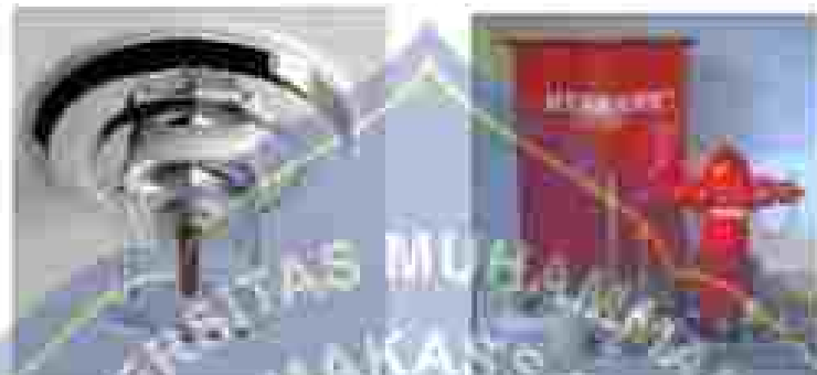
Gambar 23. Sistem Sprinkler dan Hidran (Sumber: https://www.dpr.go.id/ )
