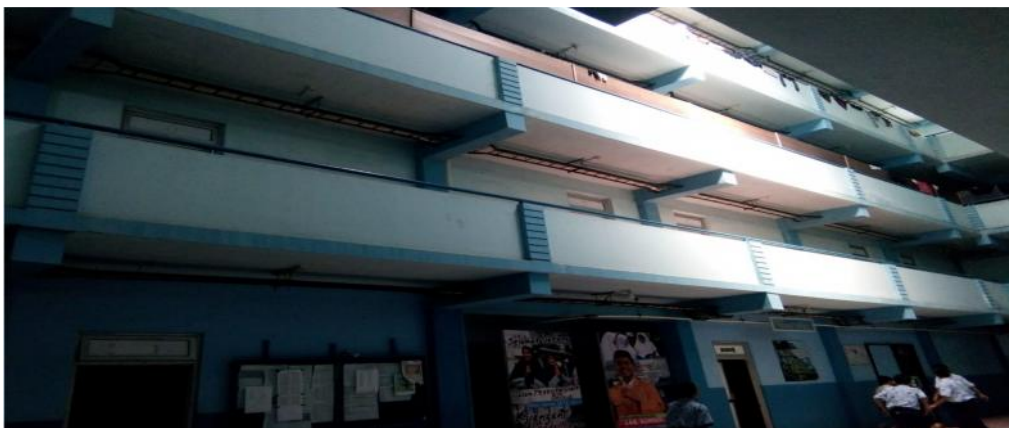
Bagian dalam gedung kantor
