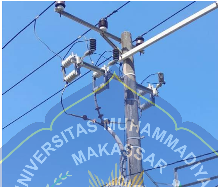
Gambar 4.2 Jaringan Kabel Tanah 20 KV
