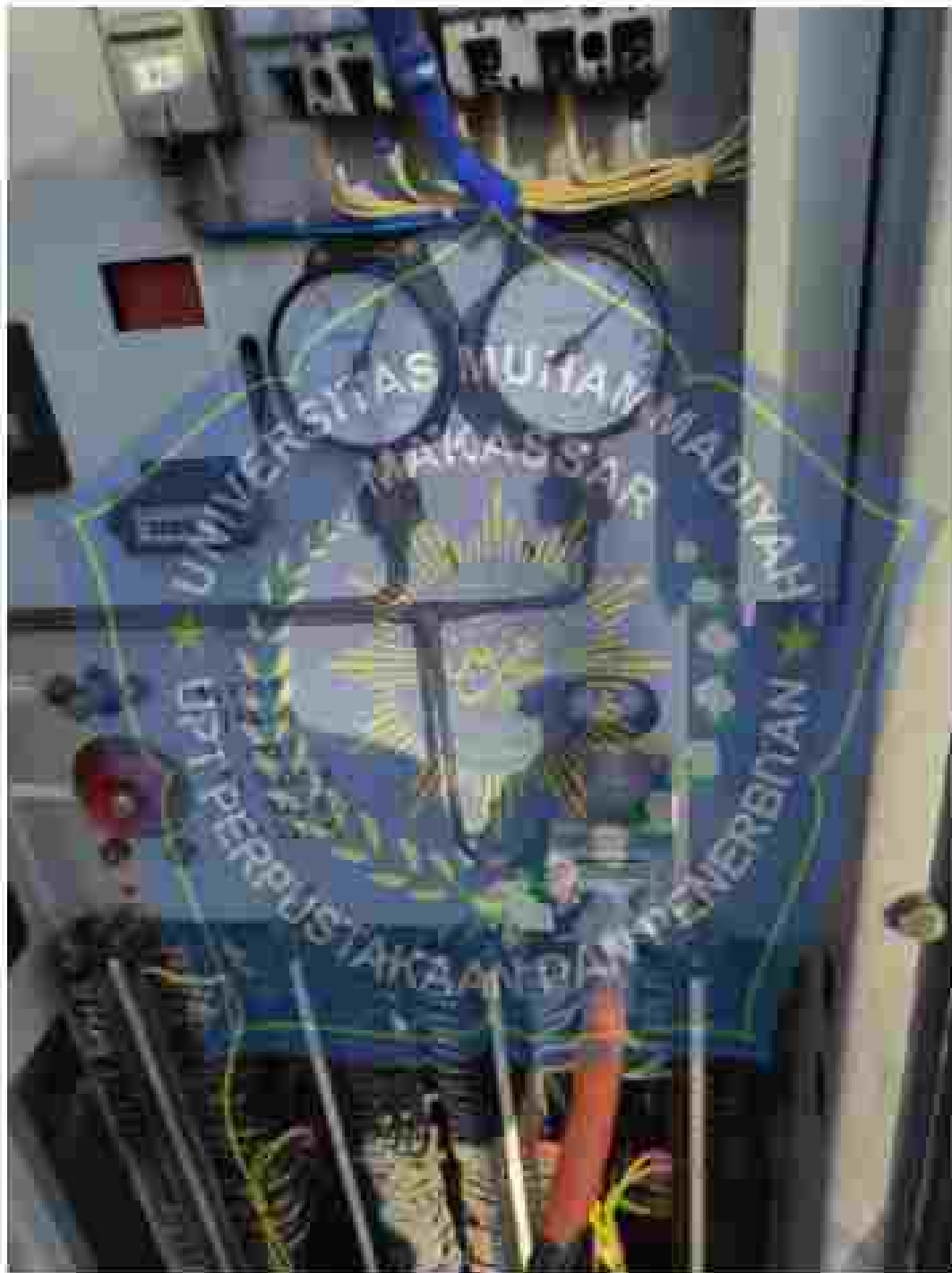
Tekanan normal gas SF 6 pada PMT Line Bontolala
