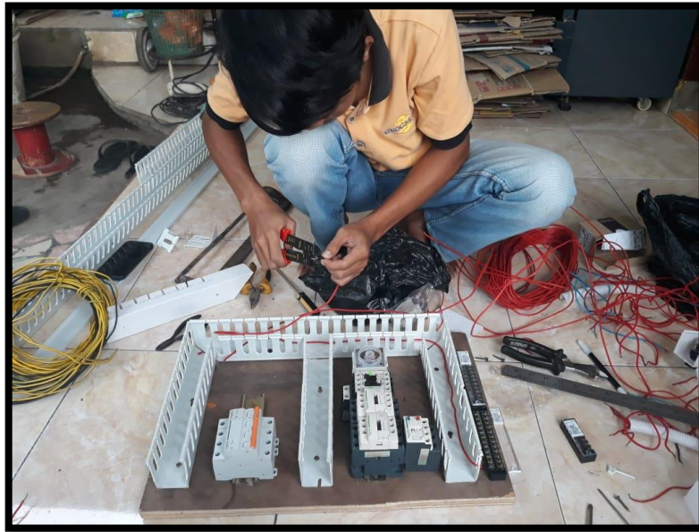
Memasang skun pada kabel
