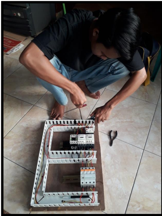
Memasang rangkaian pengendali
