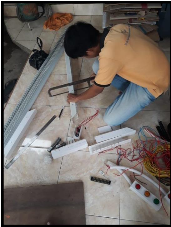
Memotong papan dan kabel duct
