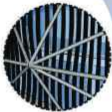
Material fasad menggunakan curtain wall, kisi-kisi kayu dan Pipa galvanis
