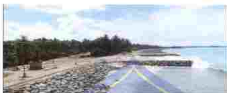
Gambar 20. Contoh Groin pada pantai (Sumber : BPSDM, 2018)
