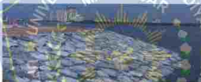
Gambar 16. Contoh bangunan revetment pada pantai (Sumber: Subriano, 2010)
