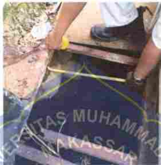
Pengecekan Ukuran Saluran Segi Empat
