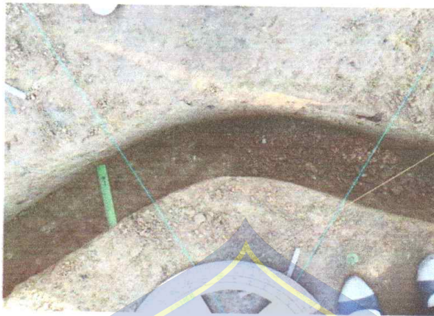
Gambar 22. Pembuatan Tikungan Saluran
