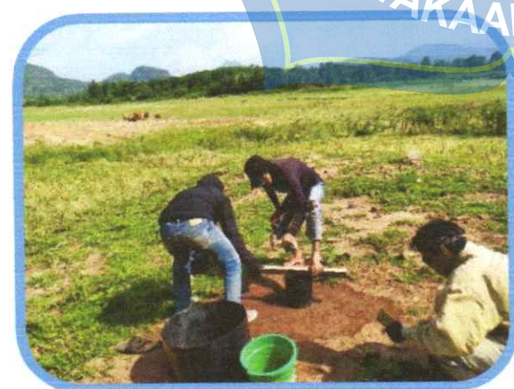
Proses pemasangan alat
