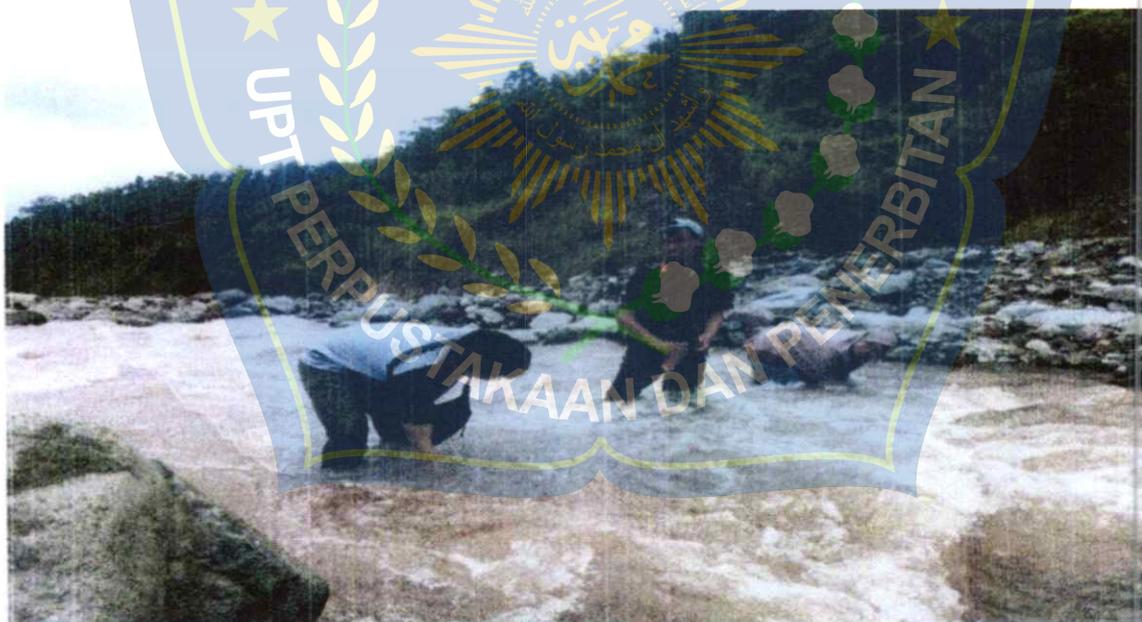
**Gambar 21. Pengukuran Kedalaman Aliran Dengan Menggunakan Tongkat
