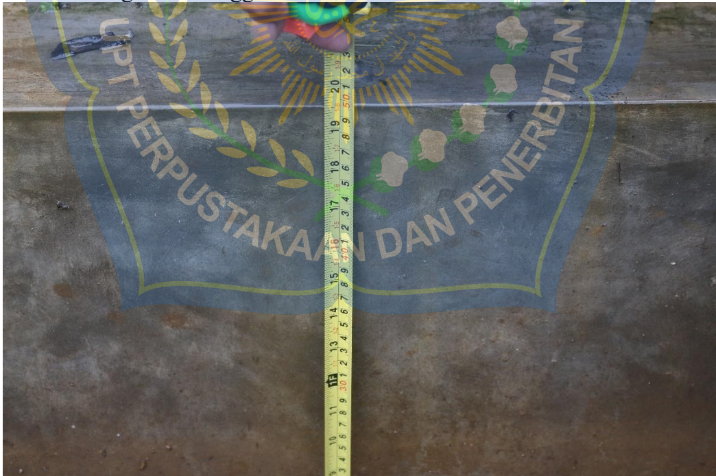
Gambar Pengukuran tinggi saluran
