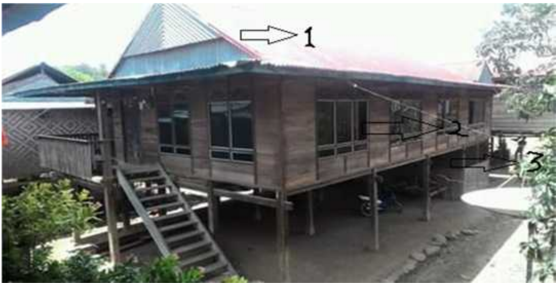
Gambar 4.1. Kondisi Rumah Panggung Tradisional
