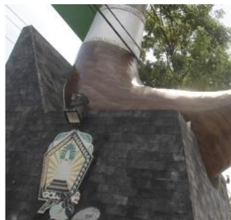
Gambar 19: Pondasi pustek perbatasan Gowa-Makassar Dokumentasi: Fatahuddin 3 April 2018
