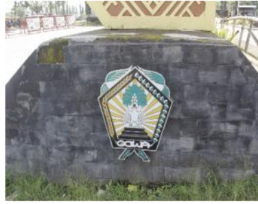
Gambar 21: pondasi pustek perbatasan Gowa-Makassar Dokumentasi: Fatahuddin 3April 2018
