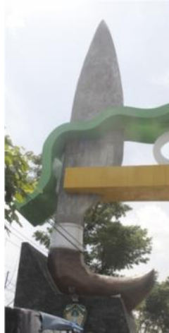
Gambar 15: Warna gapura perbatasan Gowa-Makassar Dokumentasi: Fatahuddin, 3 April 2018
