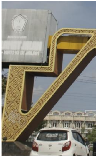
Gambar 24: Tiang tulang kontruksi gapura perbatasan Gowa-Makassar Dokumentasi: Fatahuddin
