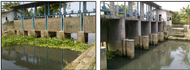
Gambar 9.5: Pintu Air Sebagai Pengontrol Air Pasang (ROB) Masuk Melewati Kanal Pabaeng-Baeng Makassar
