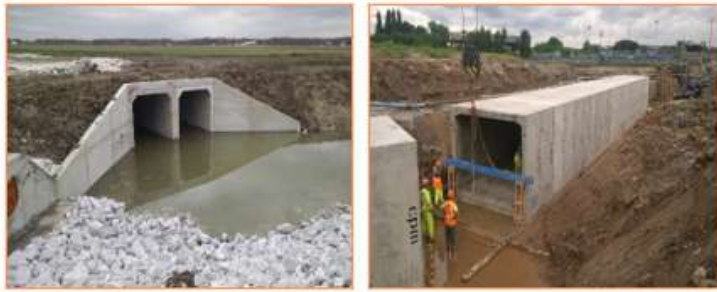
Gambar 9.4: Box Culvert Dengan Konstruksi Jalan di Atasnya
