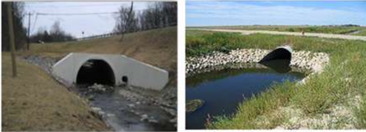
Gambar 9.3: Bangunan Pengontrolan Gorong-Gorong
