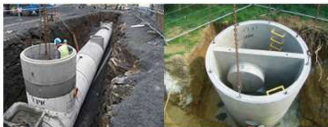
Gambar 5.1: Contoh Bak Kontrol (Manhole) Pada Saluran Tertutup
