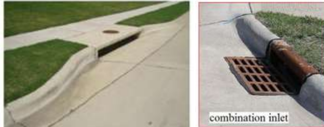
Gambar 2.12: Street Inlet ( Modul 2 Drainase perkotaan, 2017)
