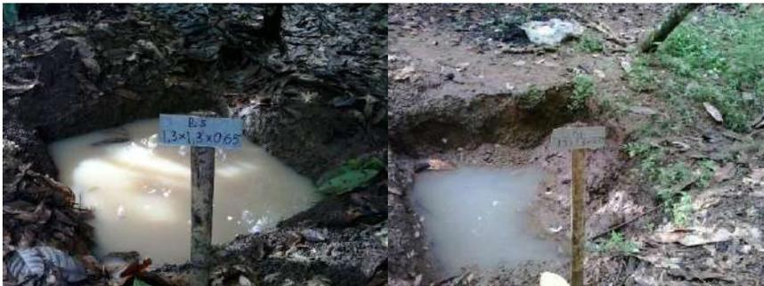
**Gambar 6. 6. Lubang penampungan air yang berfungsi untuk menahan Aliran permukaan dan sedimentasi (Suhardi et al., 2017).**
