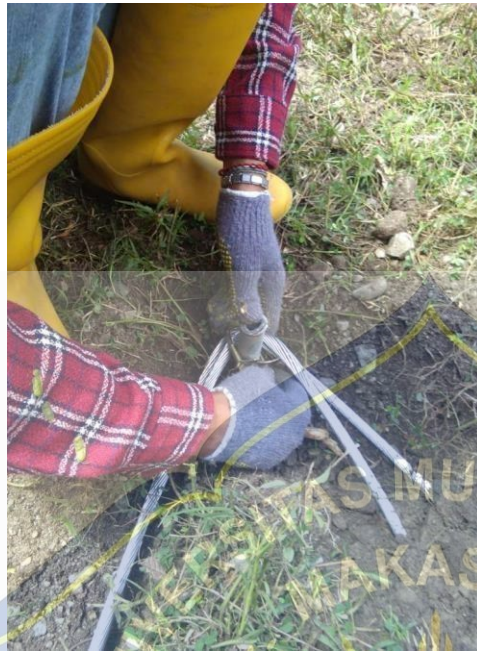
5. Proses mengikat kawat dengan dioda
