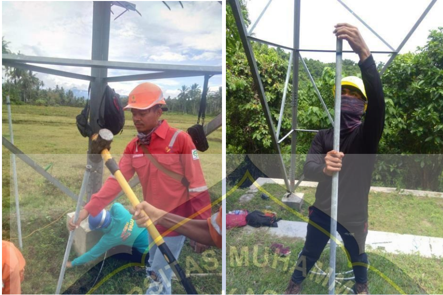
3. Penanaman Elektroda
