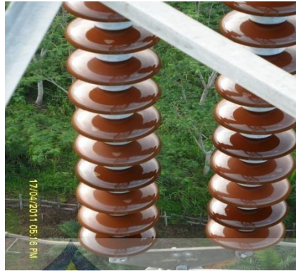
Gambar 2.3 Isolator Keramik (Sumber: ULTG Panakkukang)
