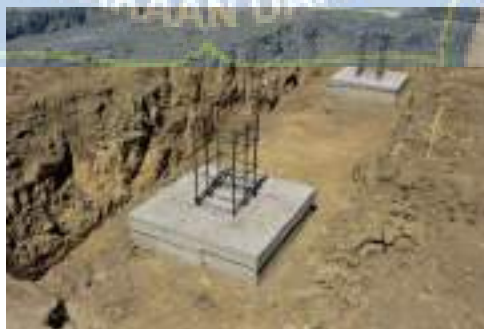
Gambar 39. Gambar Pondasi Foot Plat
