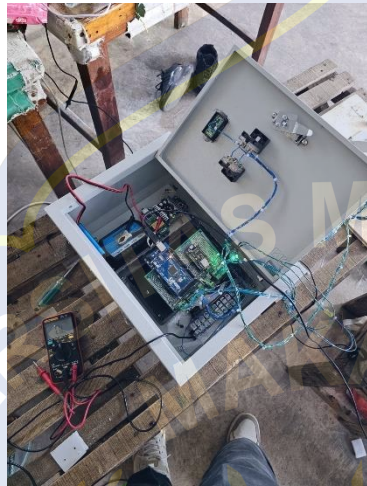
Pemasangan Alat dalam Pane
