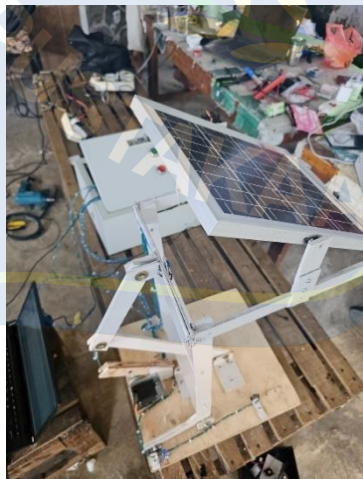
Pemasangan Rangka Panel Surya
