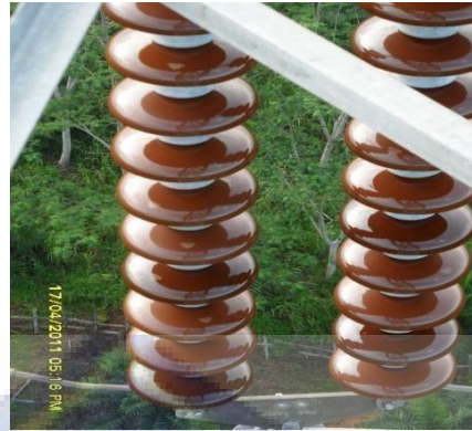
Gambar 2.3 Isolator Keramik (Sumber: ULTG Panakkukang)
