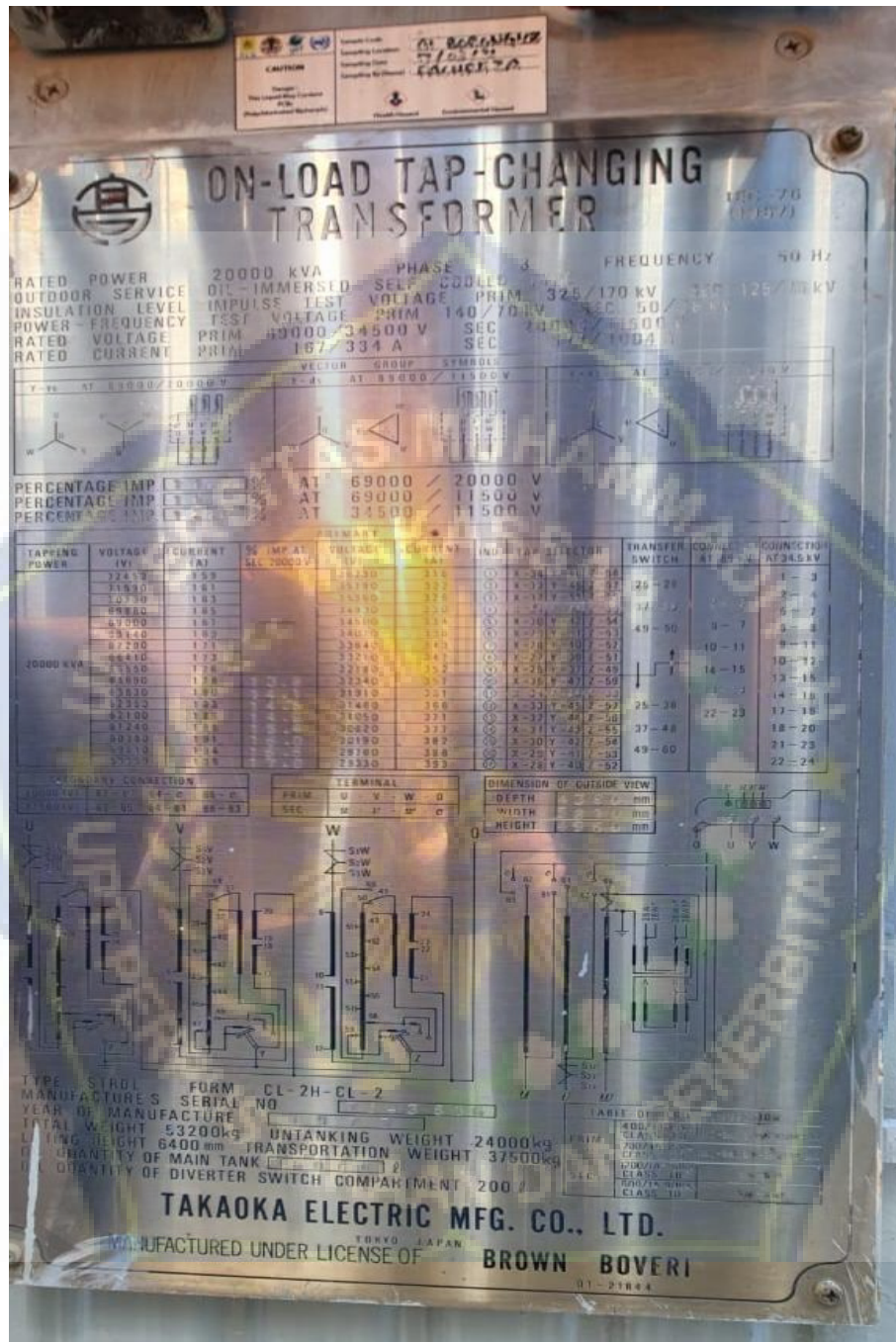
Gambar B.5 Namplate Trafo 2 GI BORONGLOE Sumber : PLN 2025
