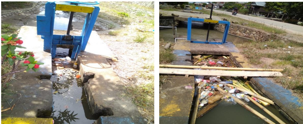
Gambar 21 : Lokasi Saluran Tersier Larumpu
