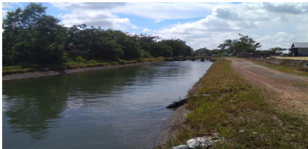
Gambar 3 : Saluran Irigasi Primer Desa Botto Kecamatan Pitu Riase Kabupaten Sidrap (Sumber lokasi penelitian)
