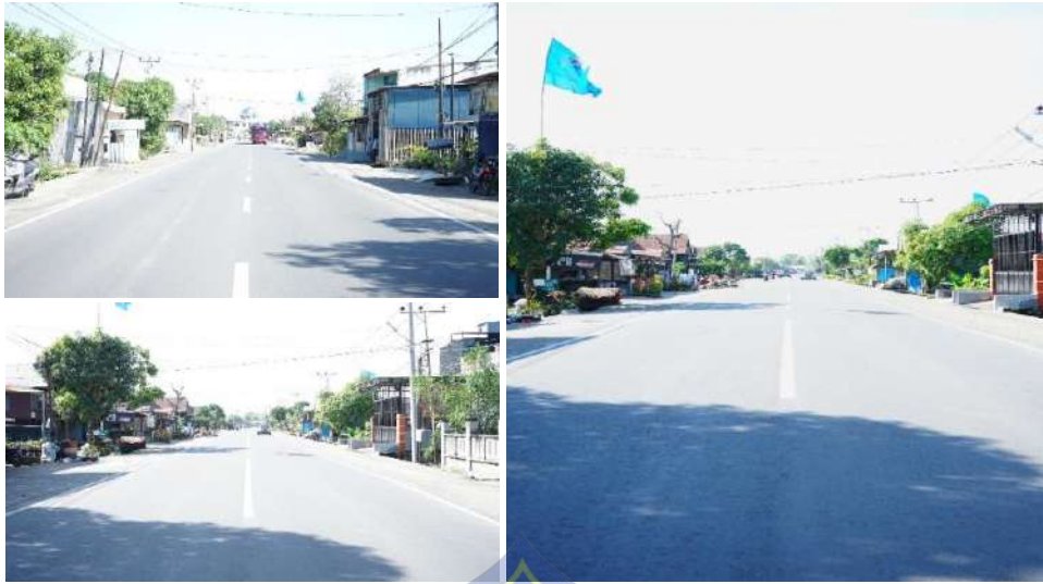
Gambar 1-13. Dokumentasi Pengerjaan Proyek Ruas Jalan : Awal Pengerjaan Sampai Penyelesaian Ruas Jalan Pinrang Rappang
