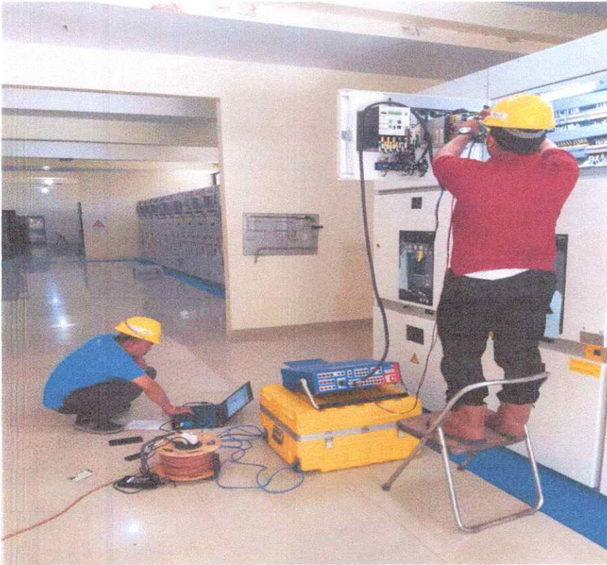
Gambar 5.8 : Pengujian Relay OCR
