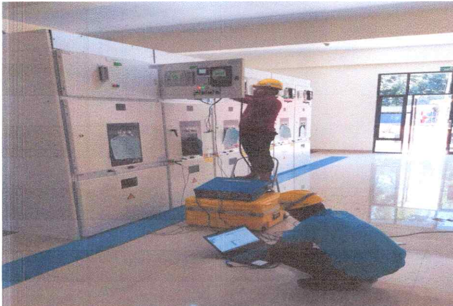
Gambar 5.9 : Pengujian Relay GFR
